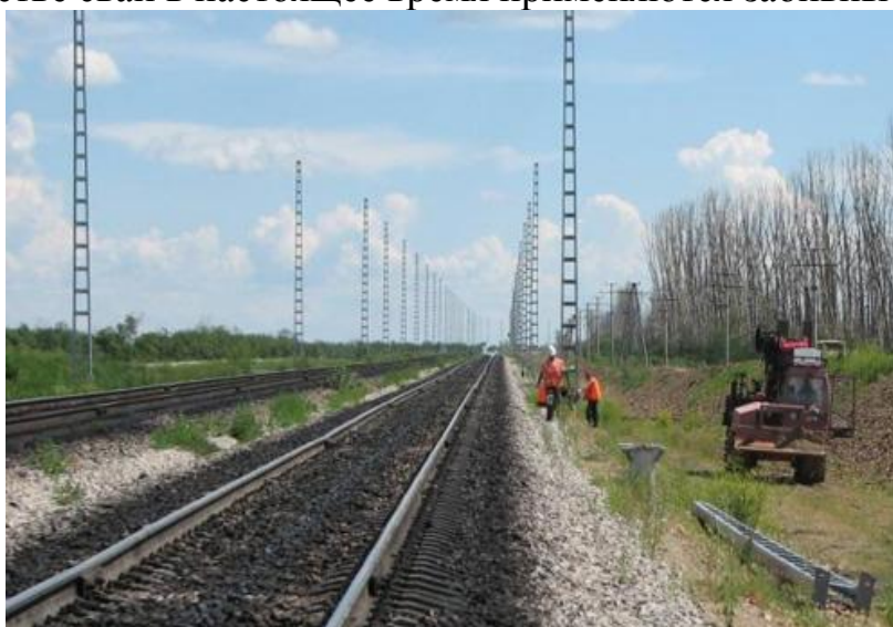
Рис.1 Возведение опор контактной сети на железной дороге
